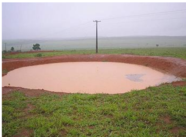
Figura 4: Barragem em Funilândia
